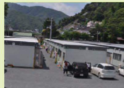
野球場の中に建設された仮設住宅
