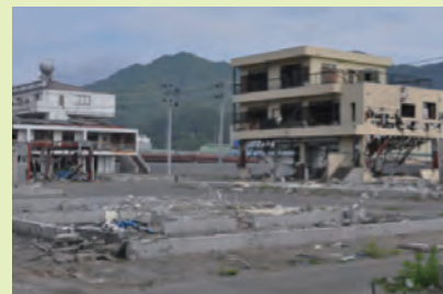
津波で1階部分が全壊
