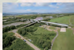
江部乙雨竜線 江竜橋架換 (下部工A1)(翌償)工事
