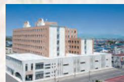
滝川市立病院改築建築工事
