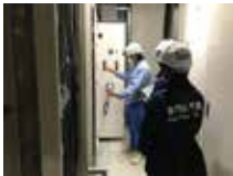
設備回路検査
