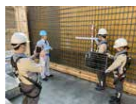
導入前の作業状況
