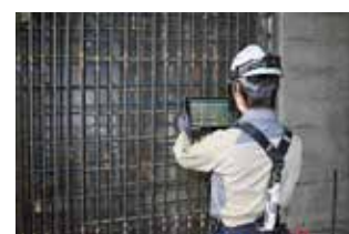
導入後の作業状況
