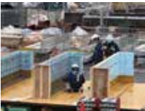
PC 配筋検査
